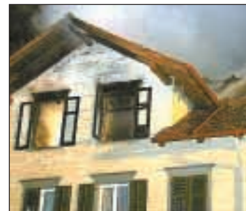
Brandherd im Dachgeschoss.
